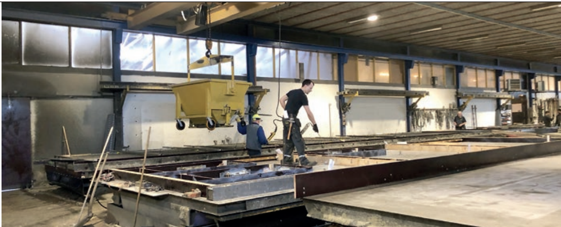
Betonstøberiet går i gang kl. 9 på PRÆFA.
